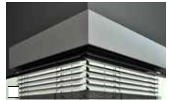
Mit Gehrungsecken (gesägt) lassen sich Eckverbindungen perfekt realisieren.
